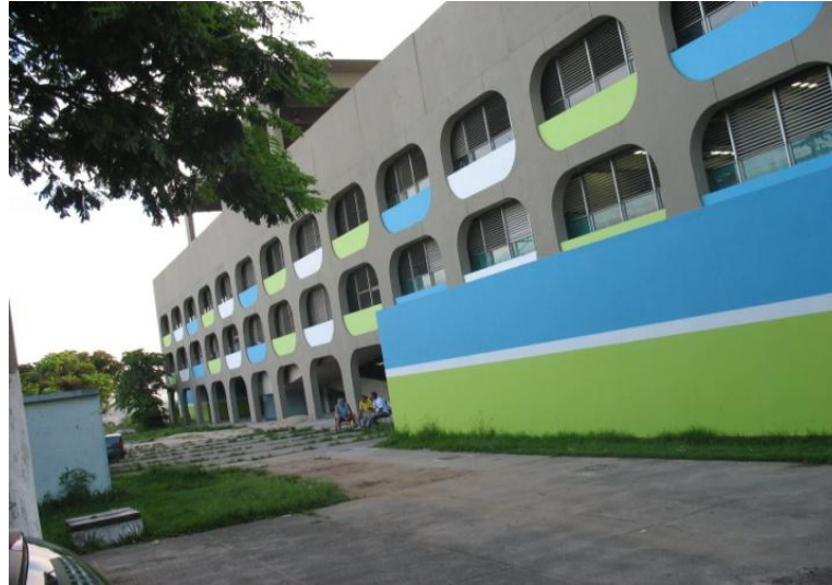
Fotografia 4 - CIEP – S. João de Meriti. Obra externa concluída. Fonte: O autor, 2010.
